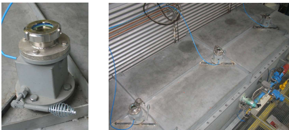
Abb. 22: Eingebaute Schauglasarmaturen.
