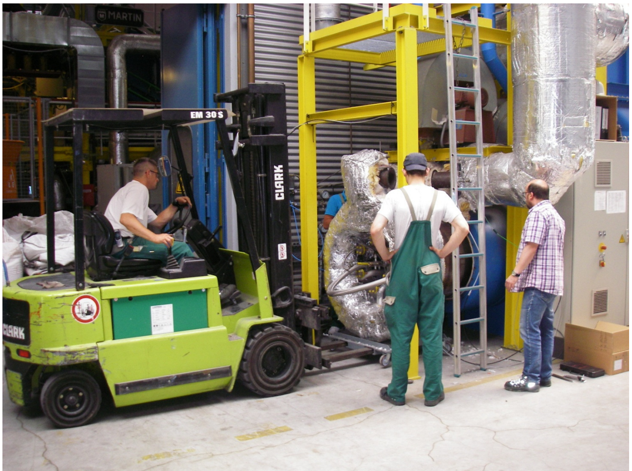
Abb. 12: Ausbau der Katalysatoren aus der Brennkammer der TNV.
