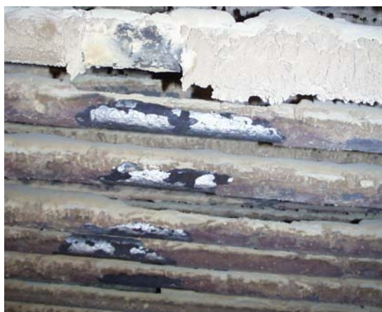
Abb. 5-12: Zustand der Rohre in der MVR, Hamburg nach Belagsbeprobung
