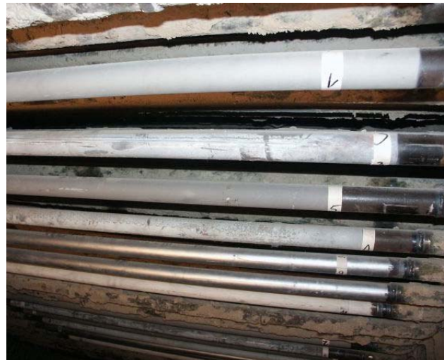
Abb. 5-11: Eingebaute Rohre in der MVR, Hamburg im August 2005
