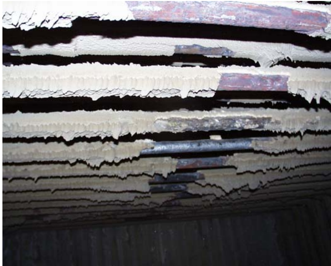
Abb. 5-15: Zustand der Rohre im GKS, Schweinfurt nach Belagsbeprobung
