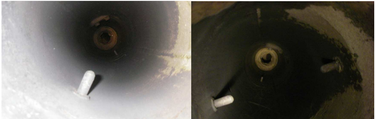
Abb. 6-1: Verbackungen im oberen Bereich der Wirbelschicht nach Entfernung des unteren Teils
