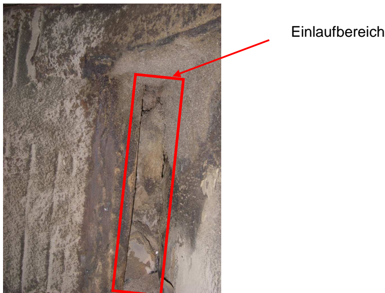
Abb. 6-3: Zugesehter Übergang von der Wirbelschicht in den Zyklon
